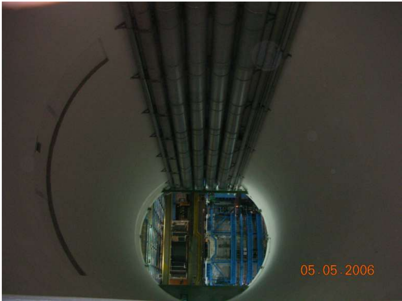
Pozzo di Atlas, con una profondità di 90m
