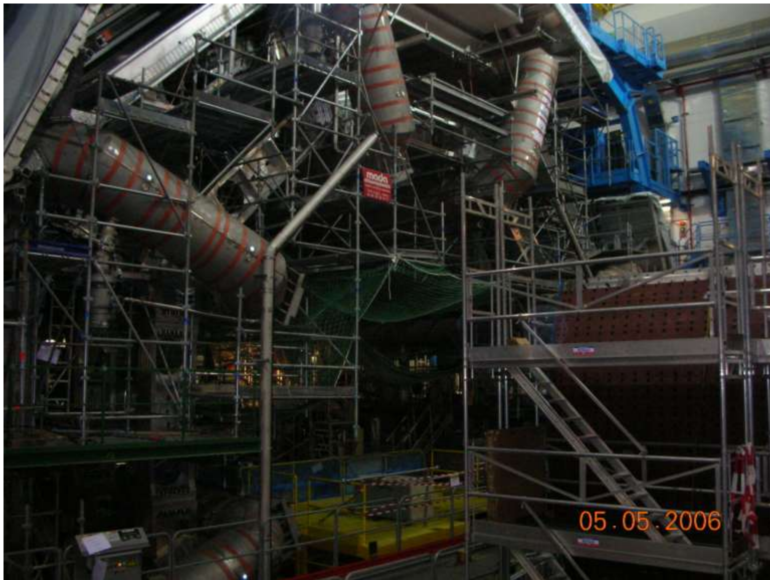
Allestimento bobine attorno alla camera principale
